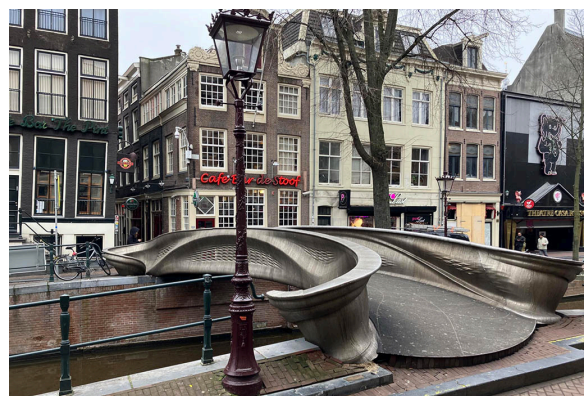
De 3D-geprinte brug bij de Stoofsteeg (foto Walther Schoonenberg)
