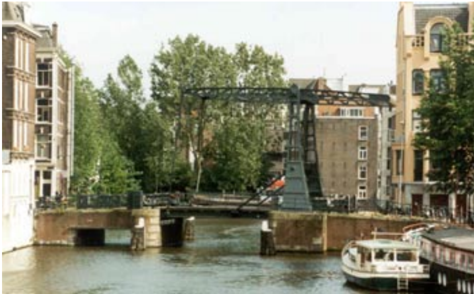
De monumentale Peperbrug tussen de Uilenburgerstraat en de Peperstraat
