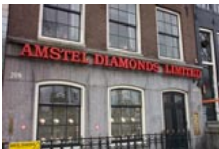
Losse letters aan de gevel
