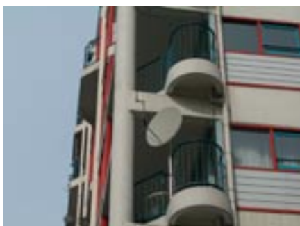
Schotelantennes aan de gevel verstoren het gevelbeeld
