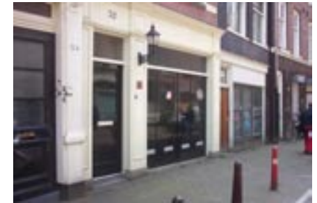
Entrees van parkeergarages dienen goed te worden ingepast
