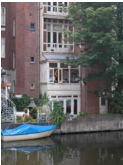
Aanbouw aan de achterzijde
