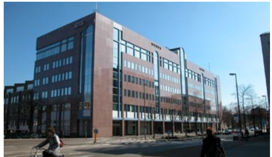
Weesperstraat; naoorlogse cityvorming ging samen met de aanleg van autowegen door de binnenstad
