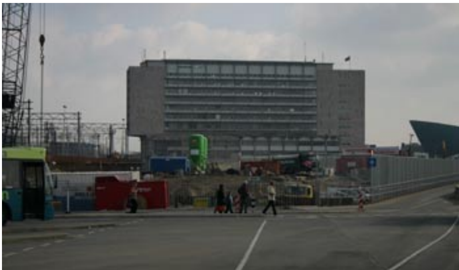
De sloop van het "PTT-eiland"
